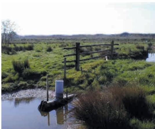
*Les casiers hydrauliques sont reliés par des systèmes de surverses et de bondes réglables.*
