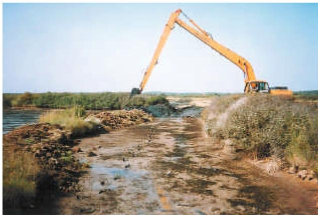
Curage et reprofilage d'un canal ensavé pour permettre la desserte en eau d'une zone qui se trouvait confinée.
