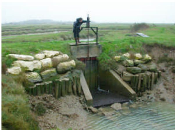
La manœuvre des vannes de prise d'eau dans les étiers est capitale pour l'alimentation des réseaux de fossés en eau "fraîche" et la vidange des bassins. Ces manœuvres sont sous la dépendance du rythme et des coefficients de marée.
