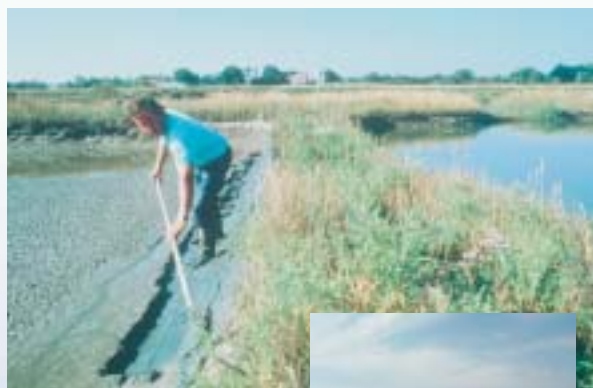
▲ Drouage (réfection des bords et des aboteaux) d'une claire ostréicole, marais de la Seudre.
