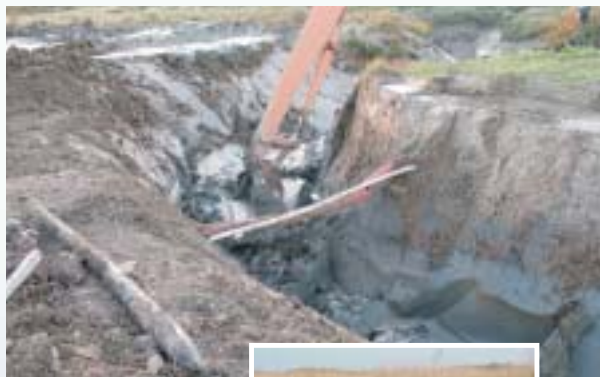
Remise en état de fossés à poissons, bassin de la Seudre
