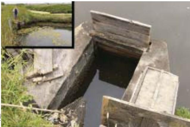
*Ouvrage de prise d'eau équipé d'un "borgnon", pour permettre au marais de boire, tout en limitant la fuite des poissons et l'intrusion d'indésirables.*
