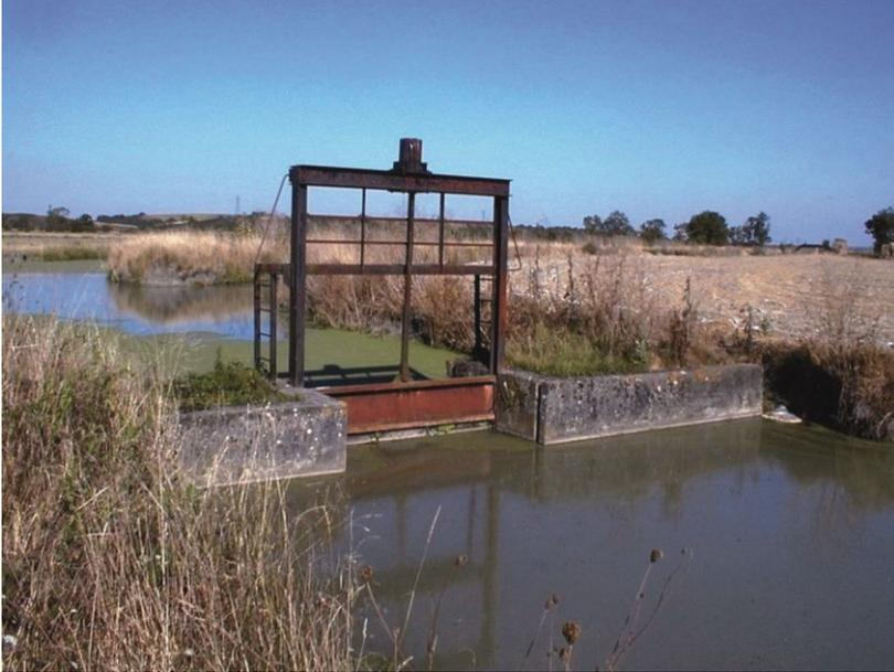
Un certain nombre de petits ouvrages conditionnent et régulent les communications entre différents compartiments hydrauliques du marais. Outre les manœuvres d'ouverture - fermeture, certains ouvrages permettent naturellement un passage facilité, d'autres non.
