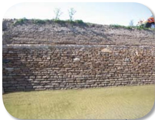
Mur à moellons horizontaux
