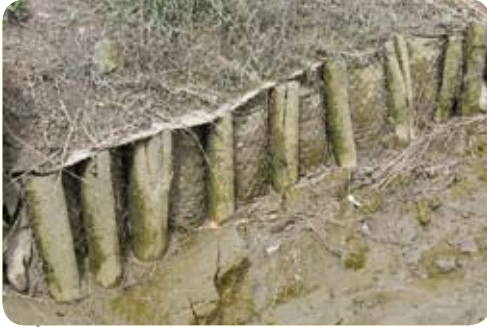
Pieux avec géotextile (Marais de La Dordogne)
