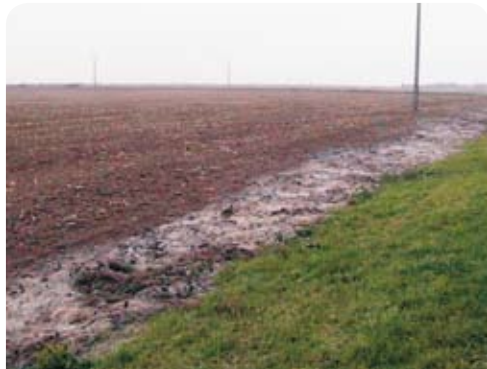
Fig.32. Comblement de fossé avec le produit de recurage d'un fossé voisin.
