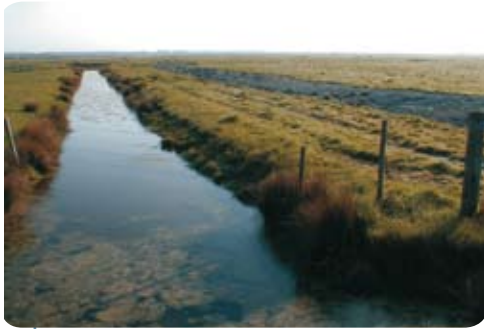
Fig.26. Le dépôt de la vase extraite se fait contre ou par-dessus l'ancien bourrelet.
