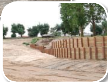
Mise en œuvre de tunage avec étagements. (Source UNIMA)
