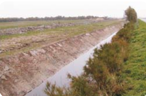
Fig.21. Recurage à blanc supprimant toutes les héliophytes
