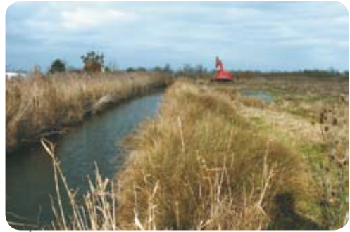
Fig.20. Curage avec respect des ceintures végétales : le résultat est invisible.
