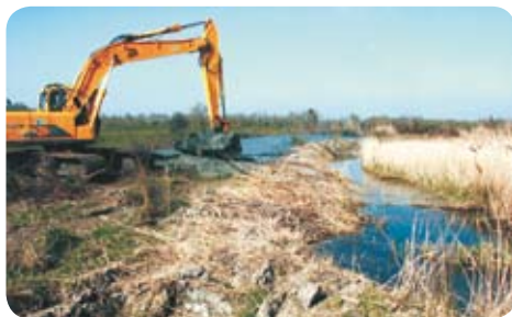
Fig.27. Dépôt de la vase avec confection d'un bourselet pour éviter son intrusion sur une roselière.
