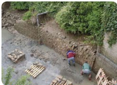
Réfection d'un mur vertical à moellons verticaux
