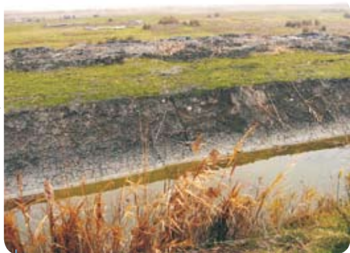
Fig.8. Fossé curé "à blanc", instable dans le temps
