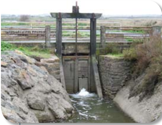
Enrochements bétonnés, dans le prolongement d'un mur, pour la consolidation des abords d'une vanne (île de Noirmoutier).
