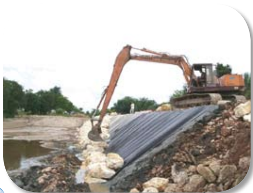
Pose d'enrochements sur couche de géotextile
