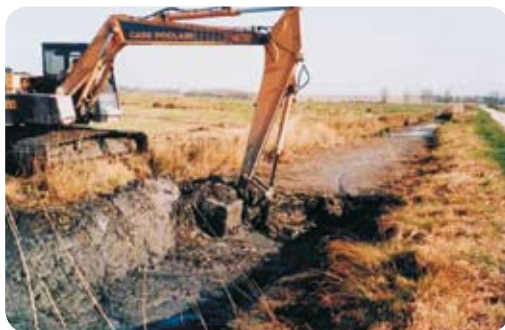
Fig.7. Re-creusement d'un fossé atterri afin de restaurer sa fonction hydraulique.
