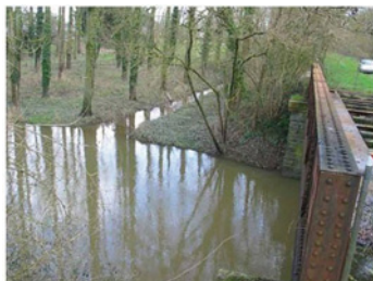
Rejet dans le Don au pied de l'ancien ouvrage SNCF de l'écoulement en provenance du nord-est de Treffieux.
