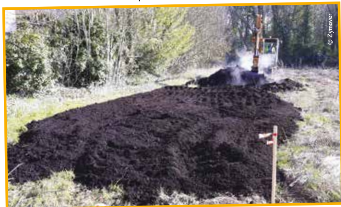
Épandage du compost de Renouées
