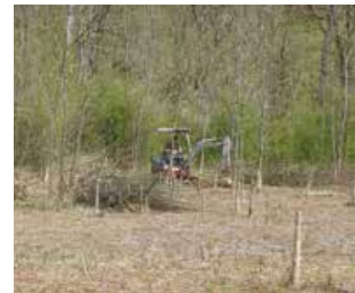
Figure 2 – Travaux printemps 2016 : dessouchage, creusement du lit et des mares
