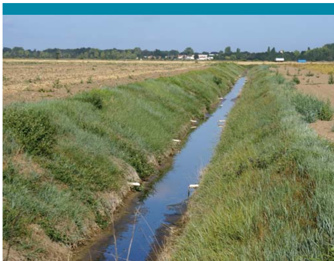
Fossé drainant traversant une zone humide
