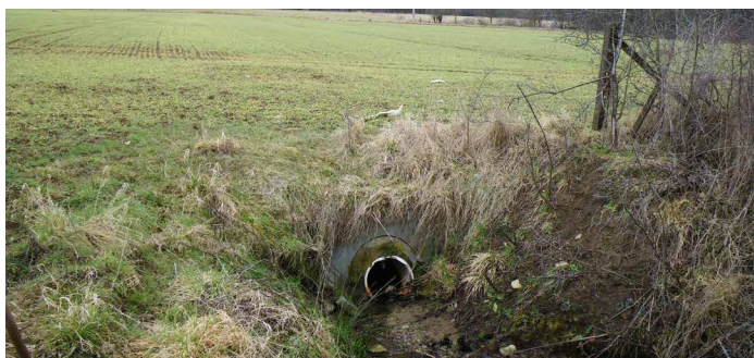
Cours d'eau enterré au centre d'une parcelle drainée (cl. OFB)
