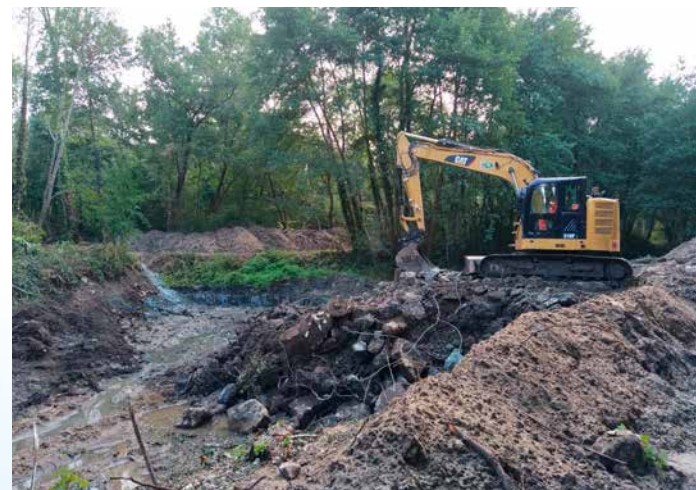
Démolition du seuil en 2023 et site post effacement du seuil en 2024 (© cl. SMBVJCC)
