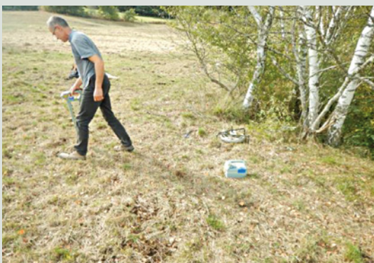
2 Suivi du tracé de la ligne de drain par cheminement sous-terrain d'une sonde de passage avec émetteur de signal (appareil de radiodétection).
