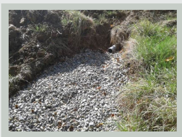
Figure 16 - Exemple et schéma de principe et d'une zone de diffusion. Issu de Mac Donald et al. 2018 31 .
