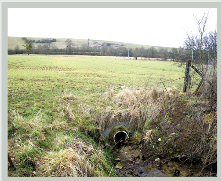
Cours d'eau de rang 1 enterré au centre d'une parcelle drainée. © OFB.
