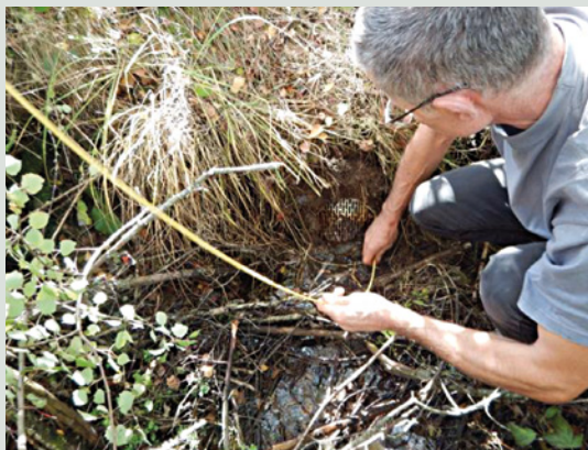
1 Repérage des exutoires de drains dans le collecteur (fossé ou cours d'eau)
