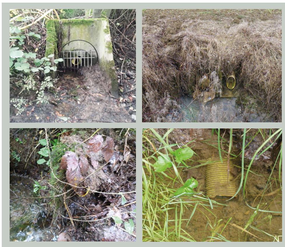
Exemples de sorties de drains plus ou moins facilement repérables selon leur nature et la présence d'ouvrage en dur. © OFB
