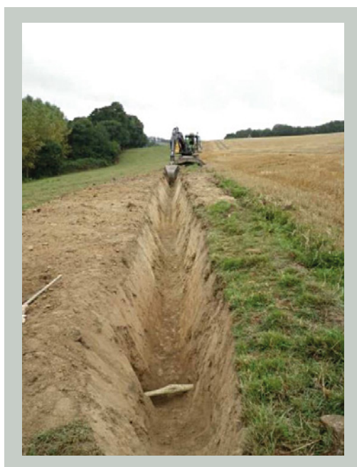
Mise en œuvre d'un fossé aveugle en bas de parcelle drainée, à l'interface avec la zone humide. © Simon Maignan, Dinan Agglomération
