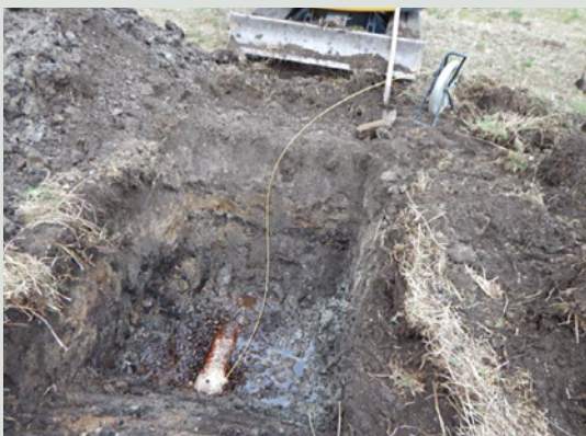
3 Excavation du sol au niveau du point de blocage de la sonde et réitération sur le tronçon suivant
